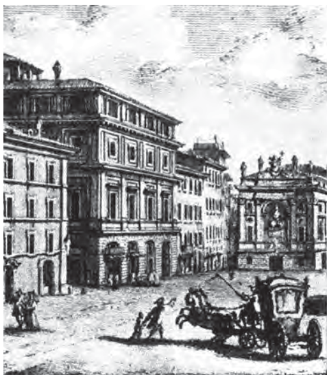
1. - Roma, palazzo Alberini nel 1756; sulla destra, di scorcio, la facciata del palazzetto che alla fine del Cinquecento aveva ospitato il banco di Ludovico Aquilani. G. VASI, Delle magnificenze... cit., particolare.
