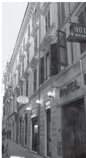
1. - Roma, edificio in via degli Avignonesi 33-35
