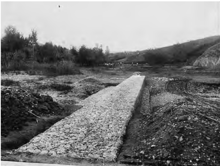
29-30. Val Sellustra (BO). Costruzione di una gabbionata nel torrente Sellustra, 1929. In ACS, ONC, Archivio fotografico, Miscellanea, Val Sellustra , scatola 13.
