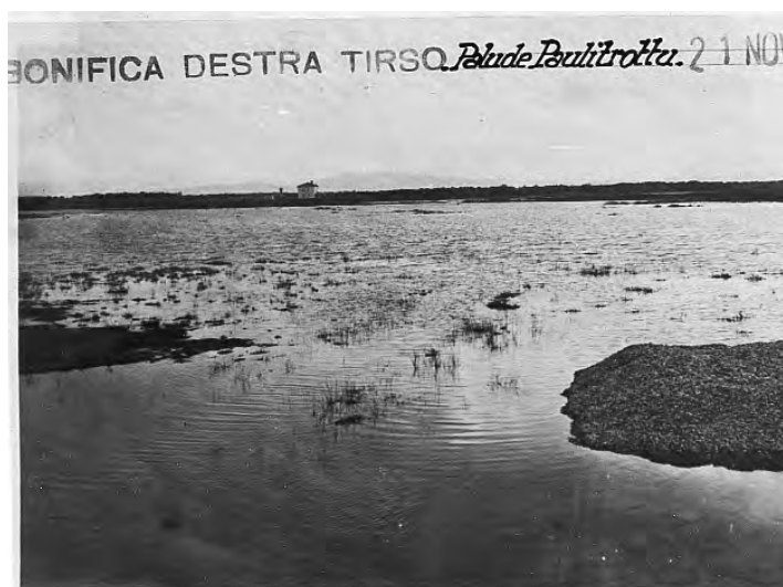
54. Bonifica della pianura di Terralba e dello Stagno di Sassu: diga del Mogoro, avanzamento lavori lato destro, maggio 1933. Fotografia allegata alla Relazione sull'attività svolta dall'Ufficio del Genio Civile di Cagliari durante il periodo dal 1° luglio 1933 al 30 giugno 1934, 15 settembre 1934 . In ACS, MAF, DGBC, Serie « Calabria, Sicilia, Sardegna », b. 257, fasc. 267.
