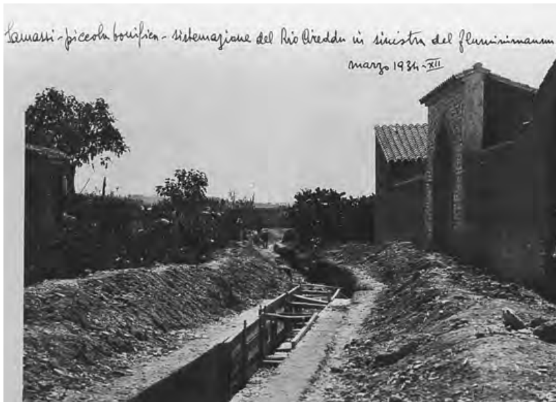
56. 57. Opere di piccola bonifica a Samassi, provincia di Cagliari: sistemazione del Rio Cireddu in sinistra del Fluminimannu, marzo 1934. Fotografie allegate alla Relazione sull'attività svolta dall'Ufficio del Genio Civile durante il periodo dal 1° luglio 1933 al 30 giugno 1934, 15 settembre 1934, di Cagliari . In ACS, MAF, DGBC, Serie « Calabria, Sicilia, Sardegna », b. 257, fasc. 267.
