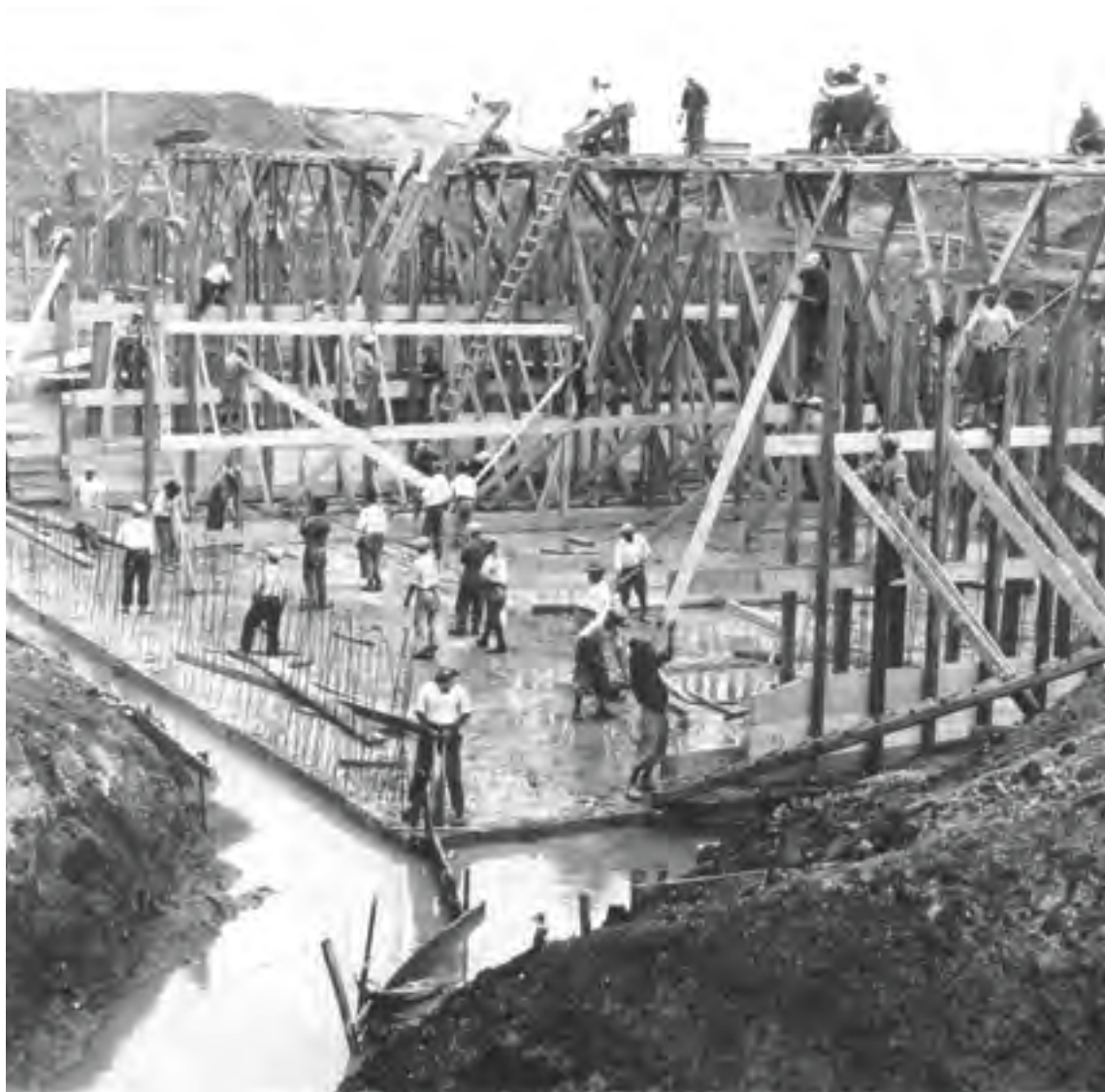
12. ARCHIVIO DI STATO DI LATINA, Consorzio della Bonificazione pontina , Fondo fotografico, album 3, n. 394: «Lavori per l'impianto idrovoro di Mazzocchio», 1934.
