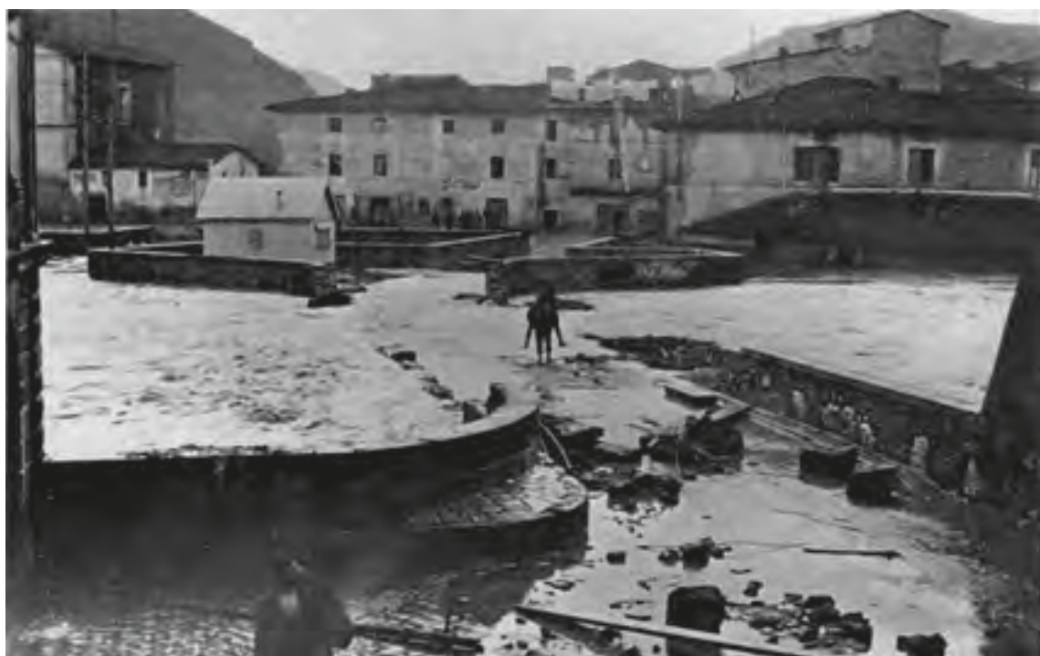
6 e 7. Gli effetti dello straripamento del Velino nei quartieri bassi di Rieti e presso il ponte romano, 1923 (Archivio privato).
