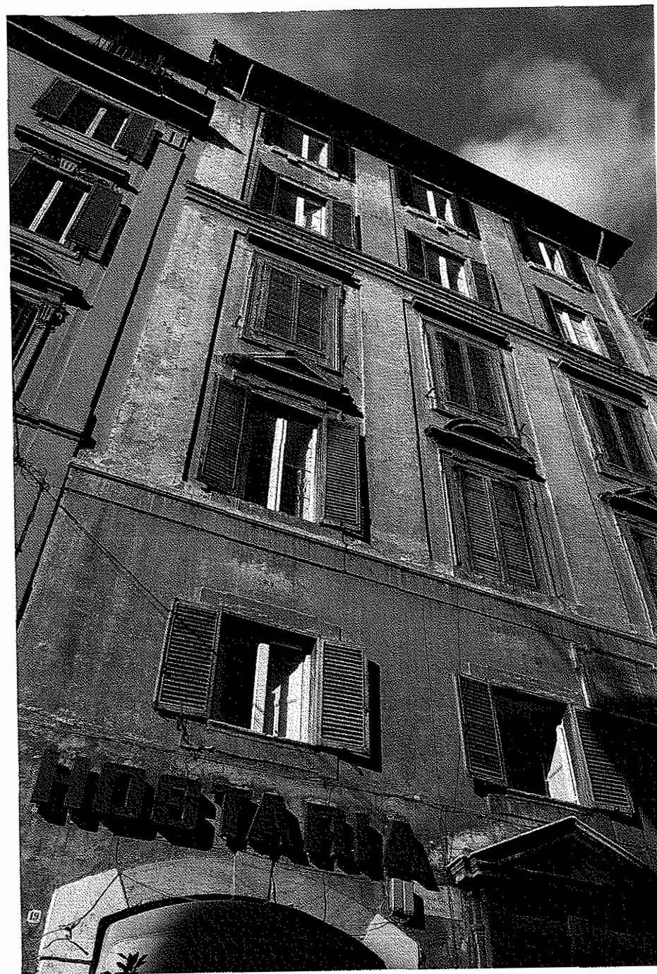
10 - Edificio in via dei Pianellari (Foto di Renato Risi, 1991)
