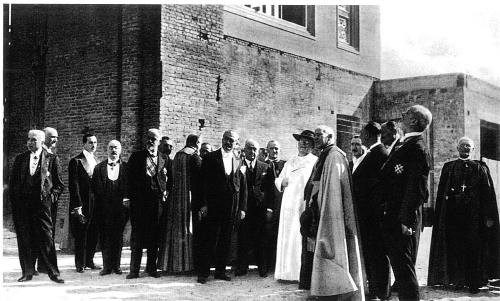
III.28. Pio XI visita i lavori per la stazione vaticana, 1930.
