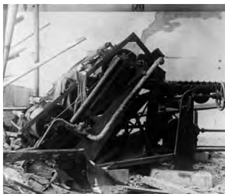
Danni ai macchinari della Tintoria.
