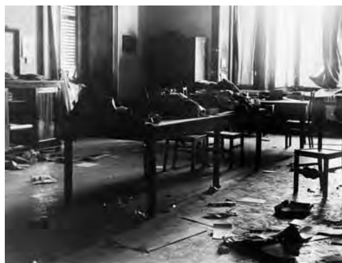
Danni subiti dallo Stabilimento - Ufficio Direzione Amministrativa.
