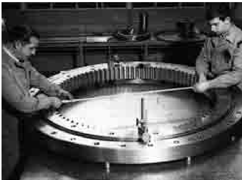
Stabilimento R.I.V. di Villar Perosa (To), Collaudo ralle nel reparto grandi dimensioni , 1950 ca. Gelatina su carta (R0649685)
